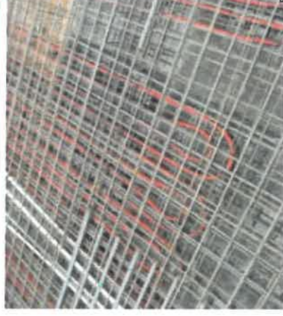
Einbringen der oberen Bewehrung
