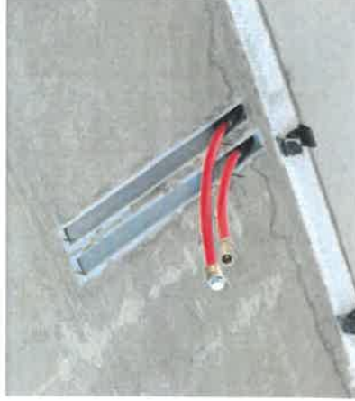
Anbindeleitung in Schalungskästen führen
