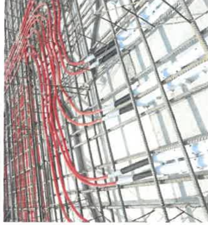
Anbindeleitung in Schalungskästen führen
