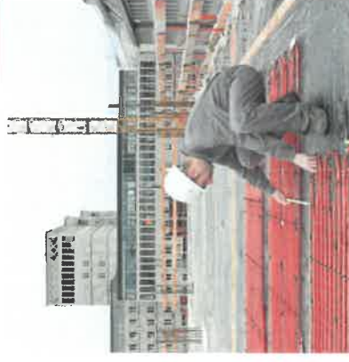
Einmessen/Ausrichten der oBKT-Module
