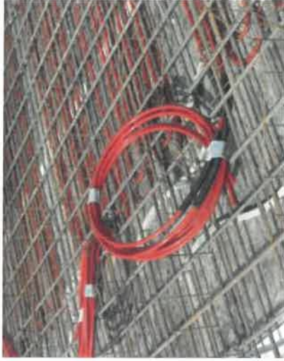
Anbindeleitung auf u. Bewehrung führen & fixieren
