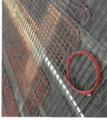
Einbringen der unteren Bewehrung
